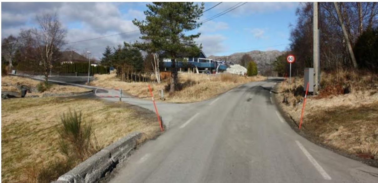
Figur 11: Bilete: Fylkesveg 248 Eikelandsvegen. Bilete tatt mot nord, like nord for Leirdalen: Vegbana er svært smal og fleire uoversiktlege kryss og utkøyrslar ligg tett på begge sider av vegen. Vegen manglar tilbod for mjuke trafikantar.
