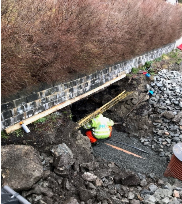
Figur 2 Arbeid med djup grøft ut frå privat eigedom
