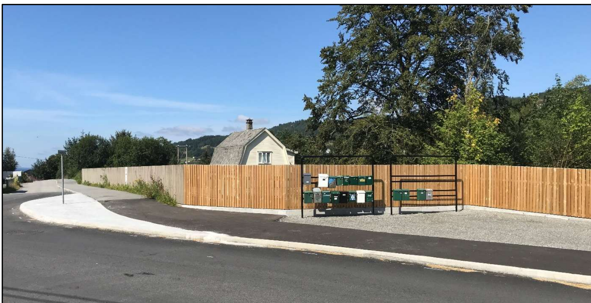
Foto viser eksisterende gjerde.
