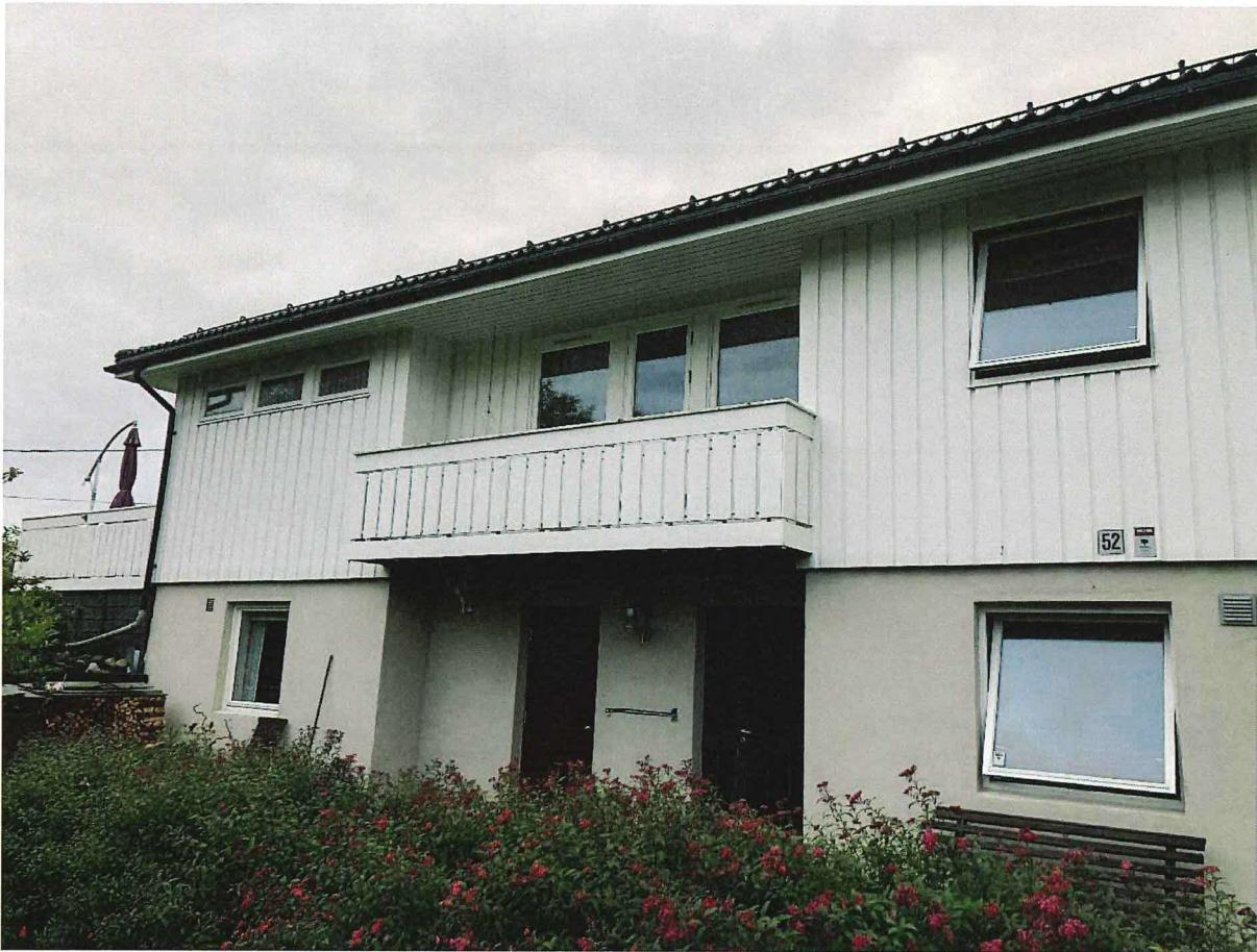
Altanen skal fjernast og kjøkkenet utvidast tilsvarende, med i alt 3,2 kvadratmeter. Ytterveggen vert trekt ut til vegg på sidene av altanen. Dagens to vindauge og altandøra vert erstatta av tre vindauge, av same type som det til høgre for altanen. Del delen av altanen som stikk utom ytterveggen vert erstatta av eit lite skråtak tilsvarande det over carport (sjå mindre bilde under).
