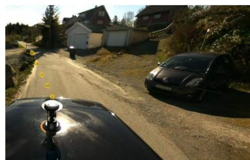
Det er ikkje lagt ved lengdesnitt som viser stigningsforhold i avkjørsla. Ihht gjeldande regelverk skal avkjørsla på den første meteren ha eit svakt fall frå kommunal veg før vegen stiger. Føremål med kravet er å sikre at overvatn ikkje vert ført ut i kommunevegen.
