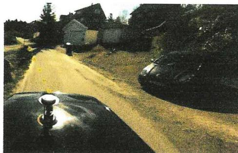
Det er ikkje lagt ved lengdesnitt som viser stigningsforhold i avkjørsle. Ihht gjeldande regelverk skal avkjørsle på den første meteren ha eit svakt fall frå kommunal veg før vegen stiger. Føremål med kravet er å sikre at overvatn ikkje vert ført ut i kommunevegen.
