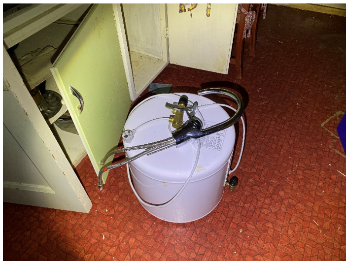
Figur 7: VV-bereder på kjøkkenet
