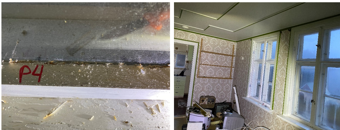
Figur 6: Kittet i dobbeltglassvinduene inneholder ikke asbest
