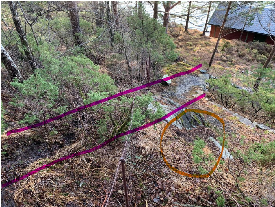
Markert lilla viser den nye bekken fra anleggsområdet inn i vår hage. For å illustrere hvor mye det til tider kan dreie seg om, var det en stor maurtue der hvor det er markert en oransje sirkel.
