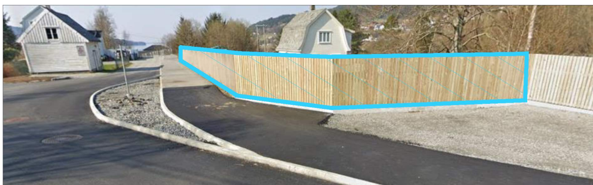
FIGUR 5 Eksisterende gjerde langs Fuglevikvegen/Lurevegen som omgjøres til støyskjerm opp til høyde minimum k+25,9.
