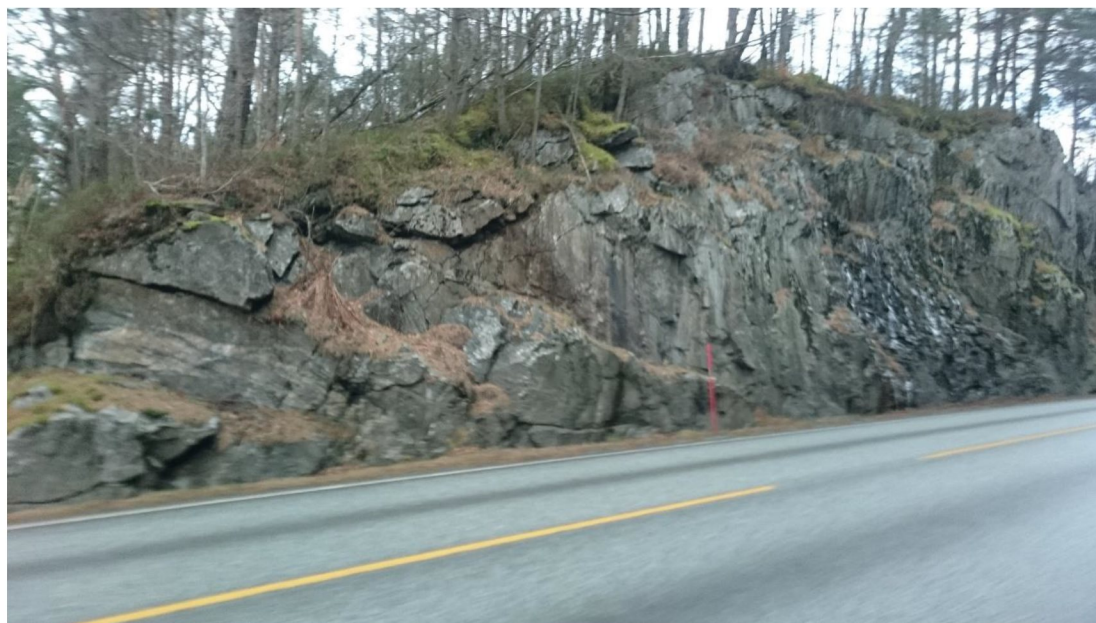
Figur 10 – Foto av eksisterende skjæring p 1000 – 1050.
