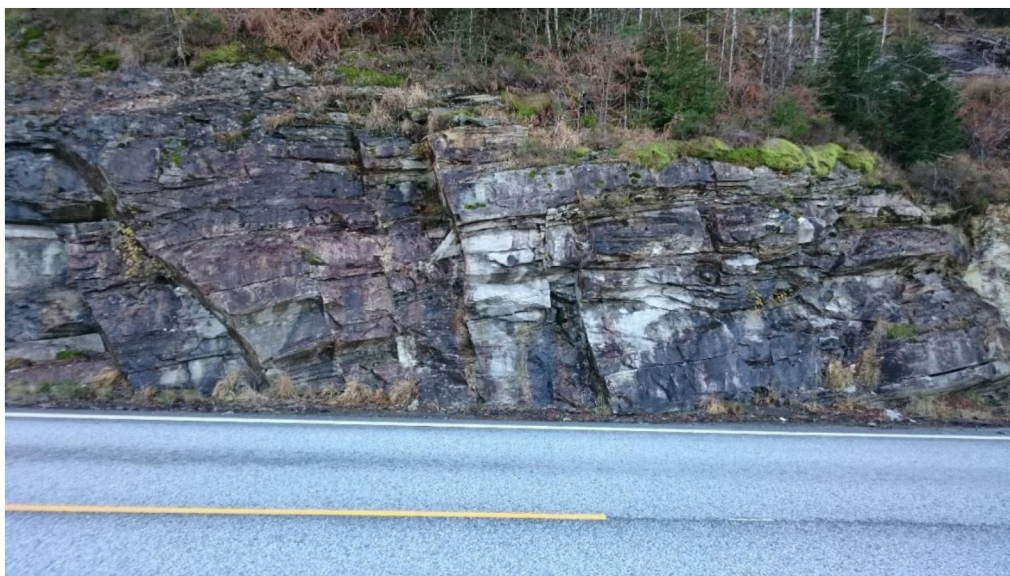
Figur 12 – Foto av eksisterende skjæring p 2000 – 2050.
