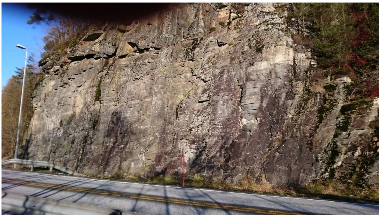
Figur 5. Foto av eksisterende skjæring p 350 – 400.
