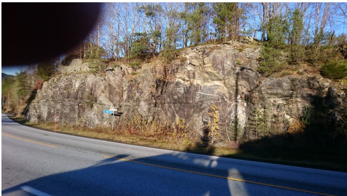
Figur 8 – Foto av eksisterende skjæring ved p 750 – 850.
