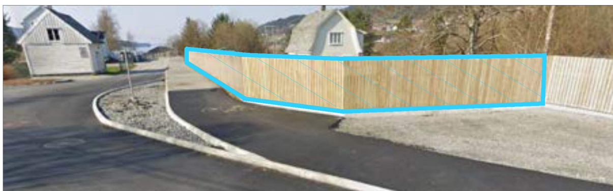
FIGUR 5 Eksisterende gjerde langs Fuglevikvegen/Lurevegen som omgjøres til støyskjerm opp til høyde minimum k+25,9.
