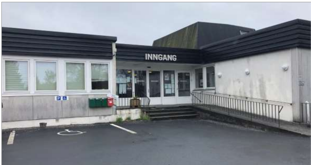
Figur 17. Hovudinngang til helsehuset, med HC-parkering og rampe.
