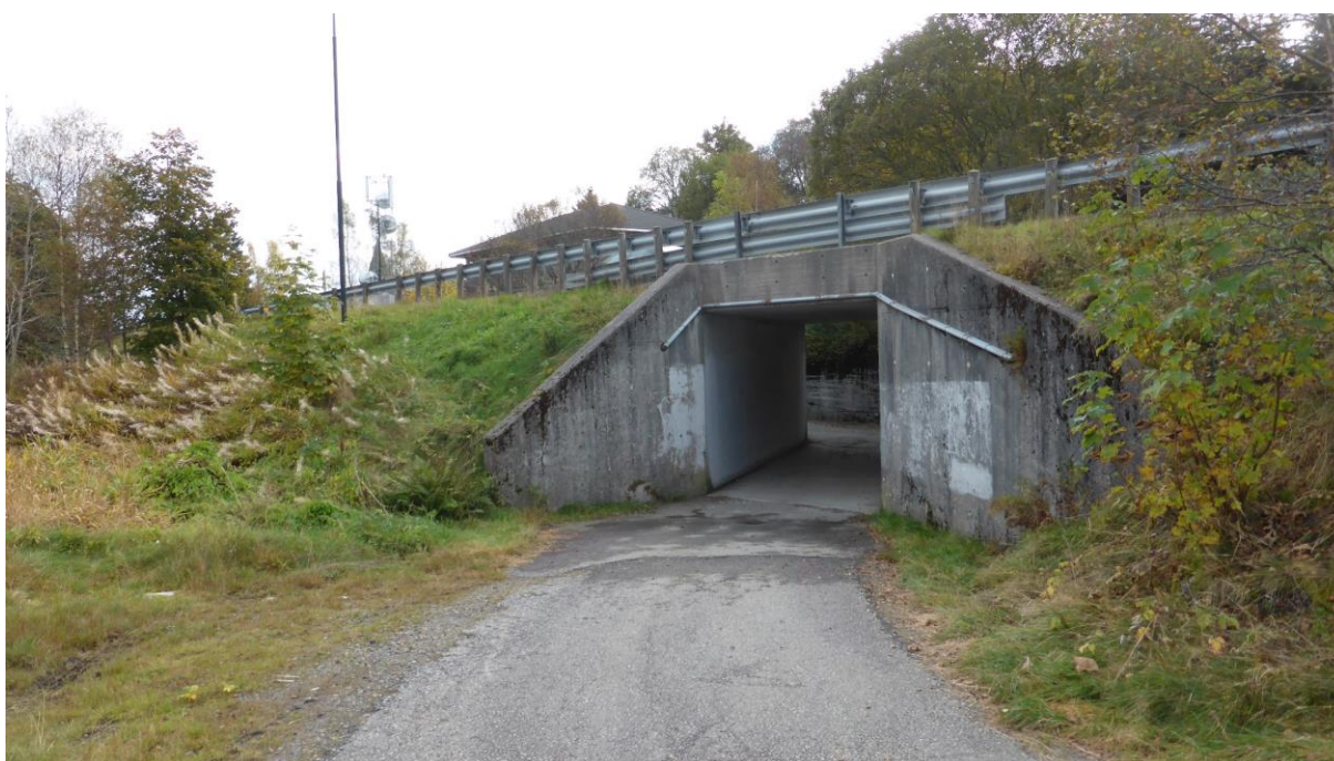
Figur 11 Kulvert under fv. 57 sør for Kolåskrysset.
