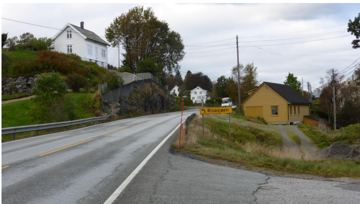
Figur 7 Husa på Lauvås ligg tett på fylkesvegen og det kuperte sideterrenget gjer vegutviding utfordrande.
