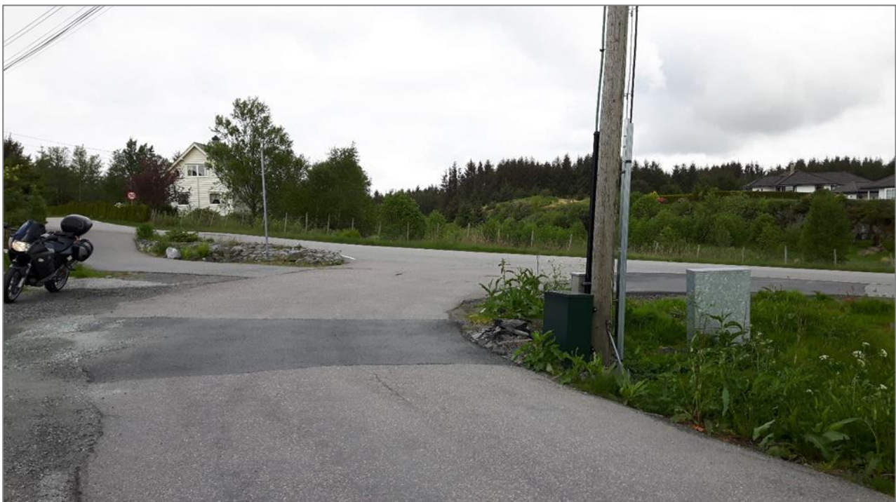
Figur 4: Kryss mot fylkesvegen (Toskavegen) – Eine tilkomstvegen til planområdet går inn til venstre på bildet.
