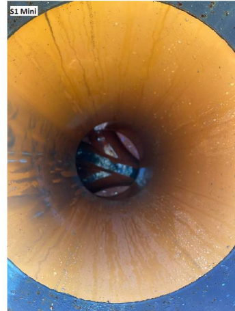
L2252022 110010 AM_S1 Mini_Eksisterende_250222_144822_40.jpg, 00:00:00, -0.10m Start inspeksjon, 0% / S1 mini
