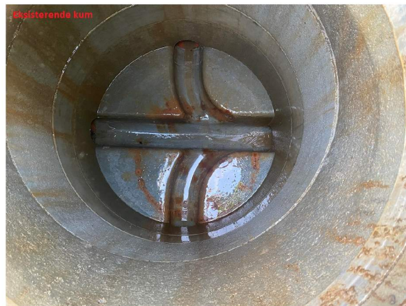
L2252022 110010 AM_S1 Mini_Eksisterende_250222_144822_42.jpg, 00:03:22, 14.70m Inspeksjon fullført / i eksisterende kum
