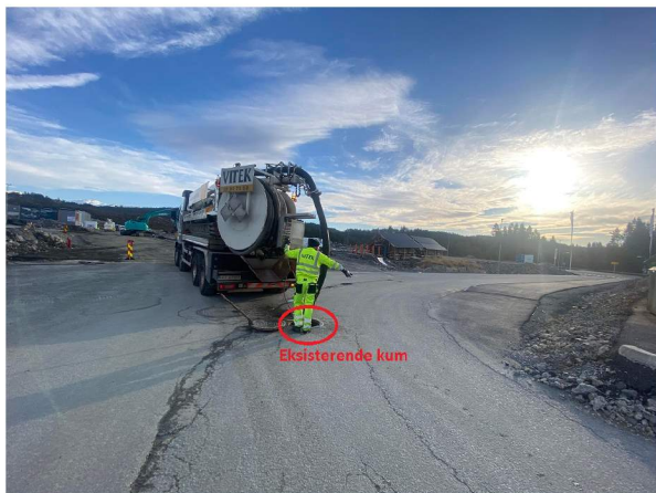
L2252022 110010 AM_S1 Mini_Eksisterende_250222_144822_41.jpg, 00:03:22, 14.70m Inspeksjon fullført / i eksisterende kum
