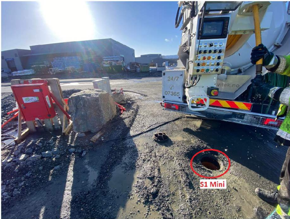
L2252022 110010 AM_S1 Mini_Eksisterende_250222_144822_39.jpg, 00:00:00, -0.10m Start inspeksjon, 0% / S1 mini
