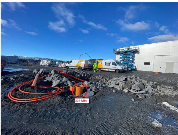
L2252022 105652 AM_S14 Mini_S5 Mini_250222_111433_11.jpg, 00:03:13, 11.40m Inspeksjon fullført / i S14 Mini
