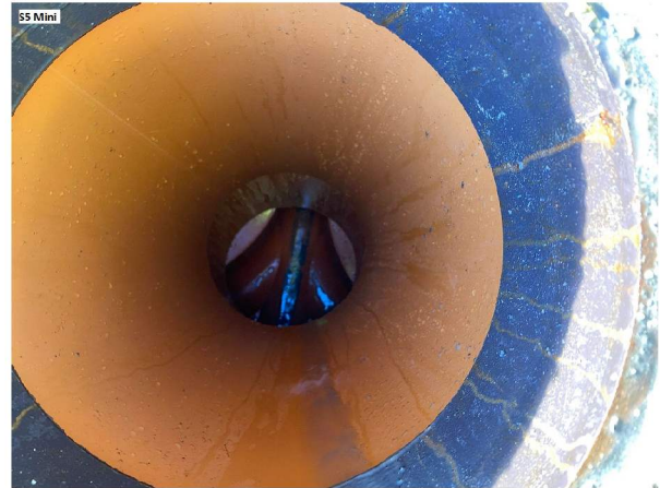
L2252022 105652 AM_S14 Mini_S5 Mini_250222_111433_10.jpg, 00:00:00, 0.80m Start inspeksjon, 0% / S5 Mini
