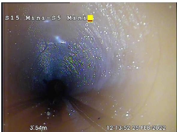
L2252022 105443 AM_S15 Mini_S5 Mini_250222_130606_4.jpg, 00:00:52, 3.70m Deformasjonen er 5 % eller mindre av rørdimensjonen, punkt deformasjon på 12 Kl. / mindre deformasjon
