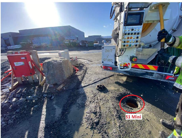
L2252022 105949 AM_S2 Mini_S1 Mini_250222_142803_47.jpg, 00:05:06, 31.90m Inspeksjon fullført / S1 Mini
