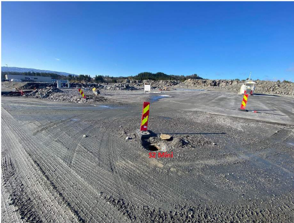
L2252022 105949 AM_S2 Mini_S1 Mini_250222_142803_45.jpg, 00:00:00, 0.00m Start inspeksjon, 0% / S2 Mini
