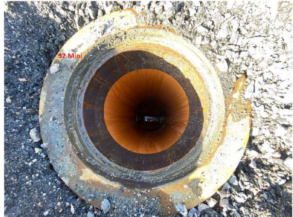
L2252022 105949 AM_S2 Mini_S1 Mini_250222_142803_46.jpg, 00:00:00, 0.00m Start inspeksjon, 0% / S2 Mini
