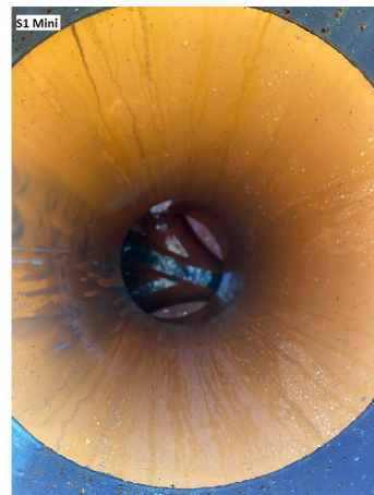
L2252022 105949 AM_S2 Mini_S1 Mini_250222_142803_48.jpg, 00:05:06, 31.90m Inspeksjon fullført / S1 Mini
