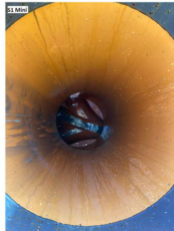
L2252022 110225 AM_S22 Mini_S1 Mini_250222_144532_36.jpg, 00:00:00, 0.00m Start inspeksjon, 0% / S1 Mini
