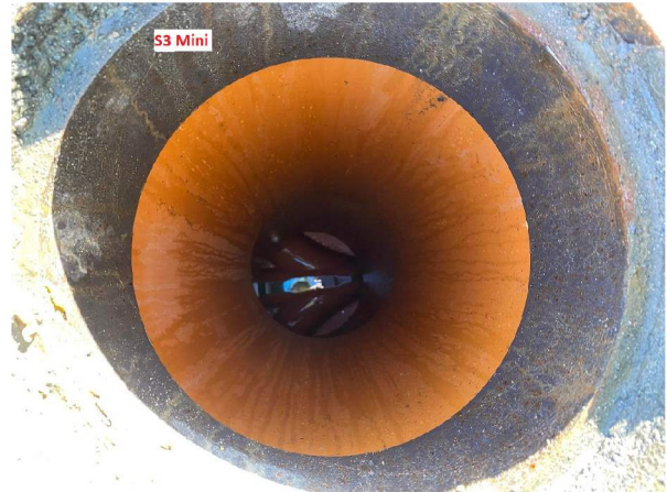
L2252022 105924 AM_S3 Mini_S2 Mini_250222_142232_44.jpg, 00:00:00, 0.00m Start inspeksjon, 0% / S3 Mini
