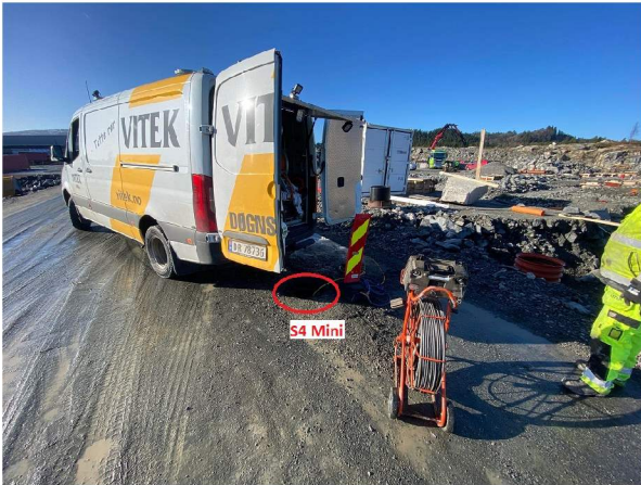
L2252022 110048 AM_S32 Mini_S4 Mini_250222_130628_21.jpg, 00:00:00, 0.00m Start inspeksjon, 0% / S4 Mini
