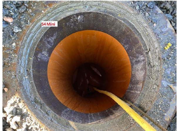
L2252022 110048 AM_S32 Mini_S4 Mini_250222_130628_22.jpg, 00:00:00, 0.00m Start inspeksjon, 0% / S4 Mini
