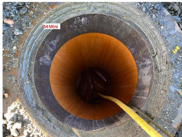
L2252022 105857 AM_S4 Mini_S3 Mini_250222_122323_18.jpg, 00:00:00, 0.00m Start inspeksjon, 0% / S4 Mini
