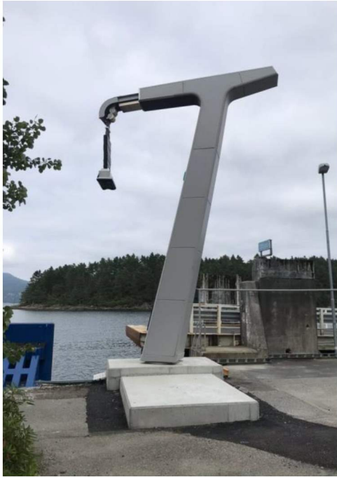
Figur 5 Eksempel på ladeplugg. Denne spesifikke installasjonen kan være 5,5 m eller 8,5 m. Lengde på arm er på dette eksemplet maksimalt 7,5 m.
