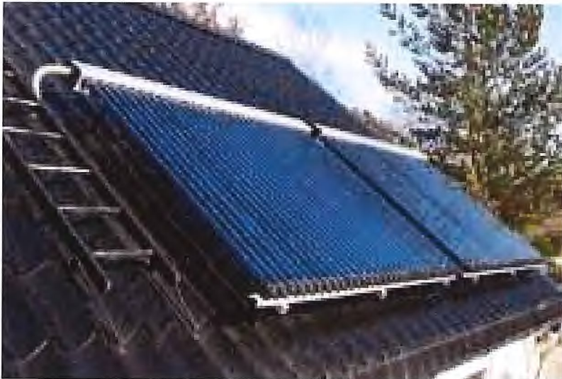
Eksempel på montering av rørsolfangere.
