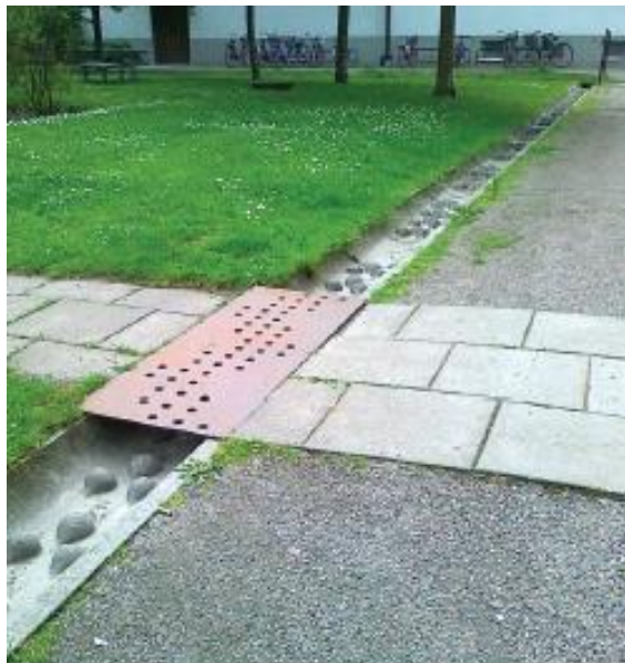
Figur 10, åpen renne for å lede overvatn.
