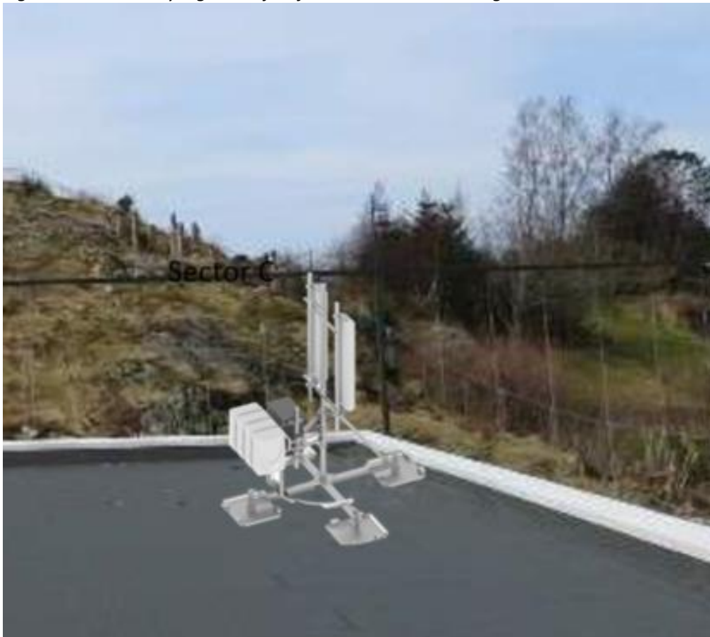
Figur 7: Sektor C Nytt gravitasjonsfeste med 2 antenner og RRU`r
