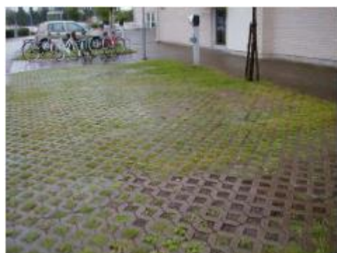
Figur 12, eksempel på permeabelt armert grasdekke (venstre) og permeabel belegningsstein (høyre).
