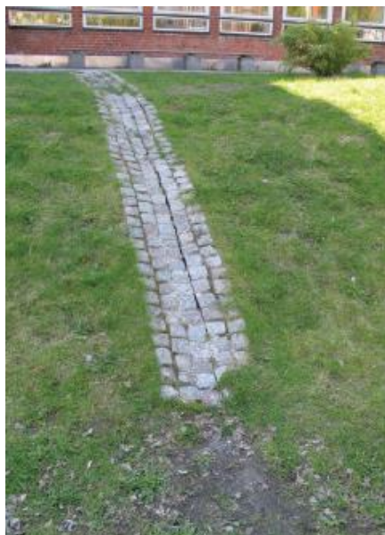
Figur 11, åpen renne for å lede overvatn.
