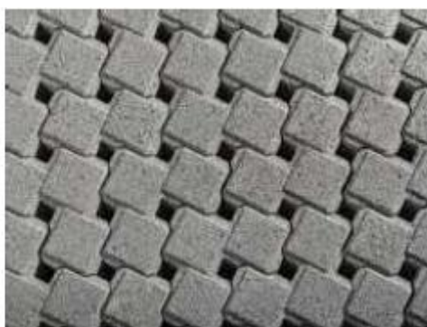
Figur 12, eksempel på permeabelt armert grasdekke (venstre) og permeabel belegningsstein (høyre).
