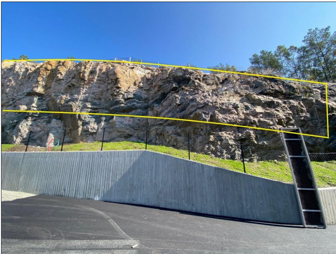
Figur 9: Anvist plassering av steinsprangnett i skjæring mellom blokk B og C og videre langs blokk C. Foto tilsendt fra oppdragsgiver.
