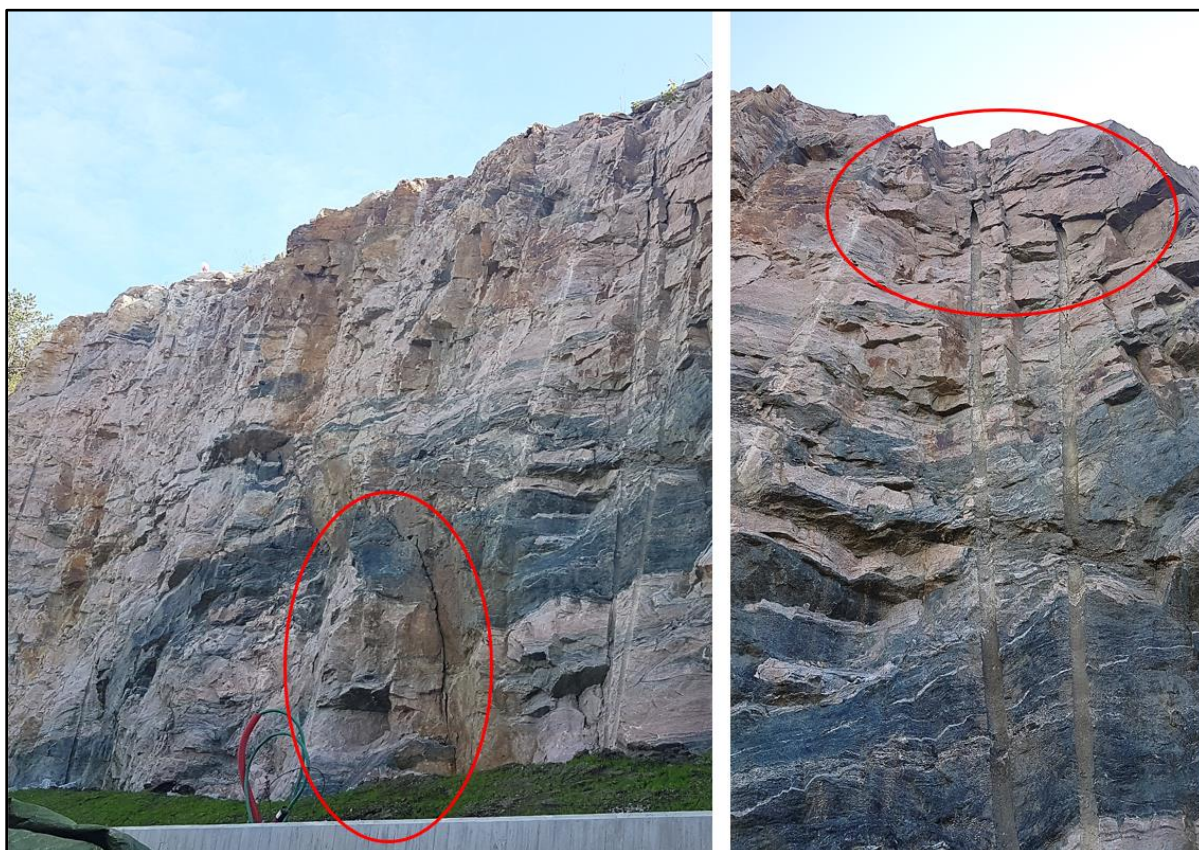
Figur 6: Anvisning sprekkeavløste blokker i skjæring mellom boligblokk B og C som må renskes. Foto: SGC
