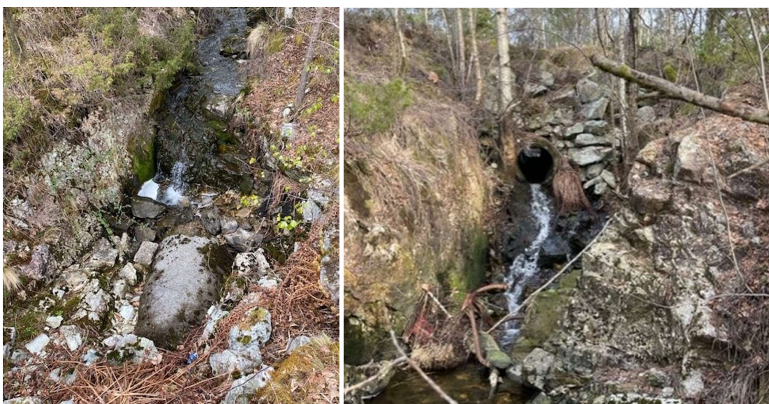
Bilde 03 og 04 Viser eksisterende rør - oppstrøms og nedstrøms gangveg
