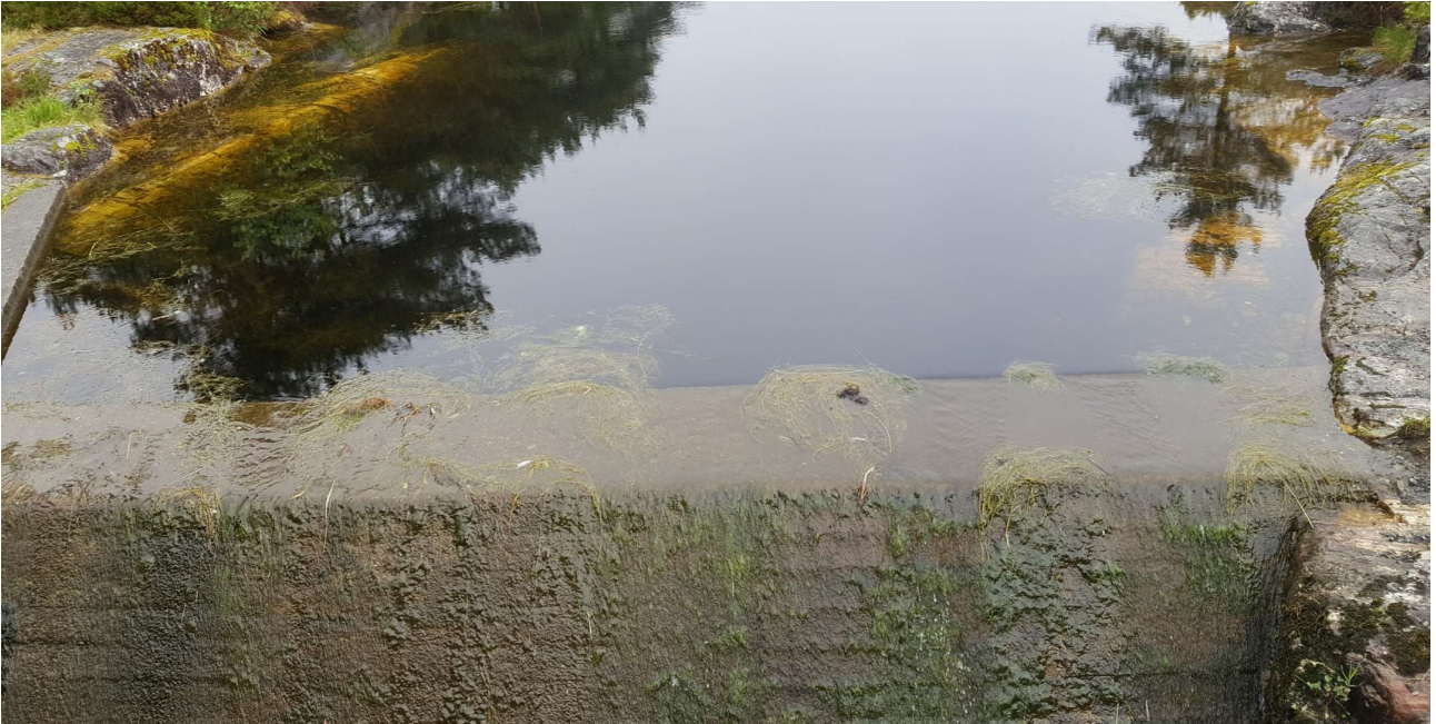
Figur 2: Dammen i Kvassnesstemma utgjør en endelig vandringsbarriere.
