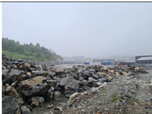
Bilde viser pågående arbeider på Mjåtveit Næringspark i nærheten av fangdam 1.
