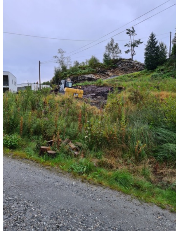
Bilde viser pågående gravearbeid på et mindre område sør for B5. Kloppedalsbekken er lagt i rør under dette området.
