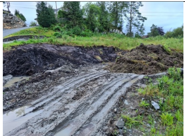
Bilde viser at det har vært gravd på et mindre område sør for B5.
