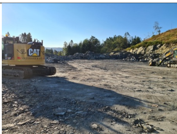
Gravemaskiner på Mjåtveit Næringspark i nærheten av fangdam 1. Var ikke aktivitet når målingene ble tatt.
