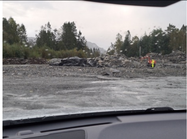
Bilde viser pågående grunnarbeider ved fangdam 1 på Mjåtveit Næringspark.
