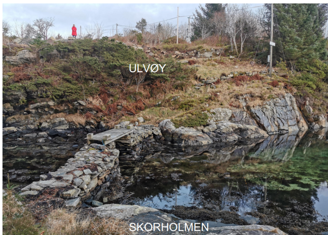
Fig. 1. Steinbrua. Tilkomsten ned til steinbrua frå Ulvøya må kallast ei «rås» (enkel sti). Kjelde: Ramme- søknad v/ Kvalbein Korsøen Arkitektur AS.
