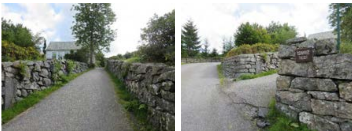
Figur 6-8 Foto til høgre viser gangveg med tilhøyrande murar på begge sider. Foto til høgre viser nedre del av gangveg som må omarbeidast. Foto: Asplan Viak AS.
