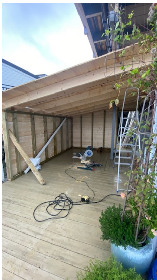
Innvendige vegger før panel
