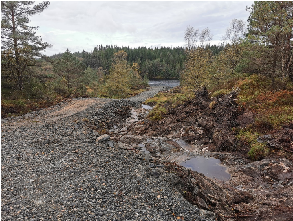
Fig. 4. Den mellombelse anleggsvegen som skjer over både gnr. 113, bnr. 2 og «hestevegen».
