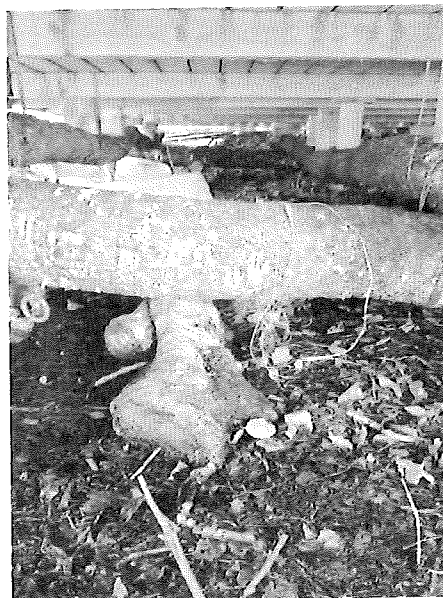
Bildet viser stukkene som ligger i myren, og tredekket som hviler på disse.
