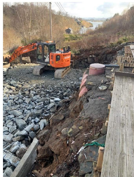
Terrenget øst for hytten med septiktank, etter at terrengmuren er fjernet.
