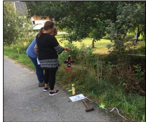
Figur 1: Ytterpunkt for avkjørselen er vist med gulestikker (mot øst)
