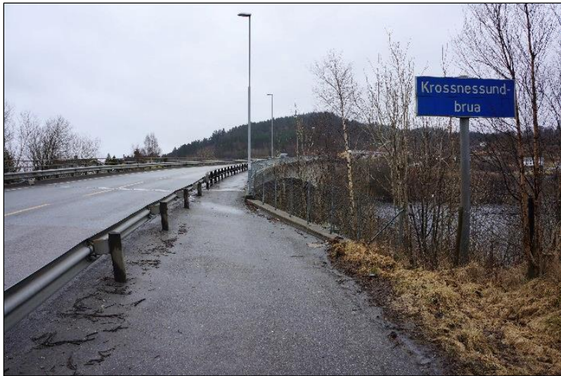
Gang-/sykkelveg i retning mot Holsnøy, over Krossnessundbrua.
