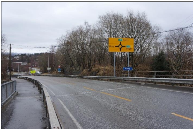
Fv.564 frå brua mot rundkøring, i nordleg retning.
