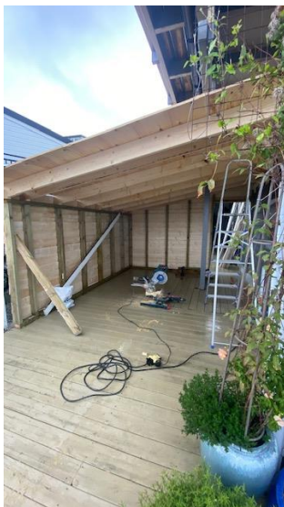
Innvendige vegger før panel
