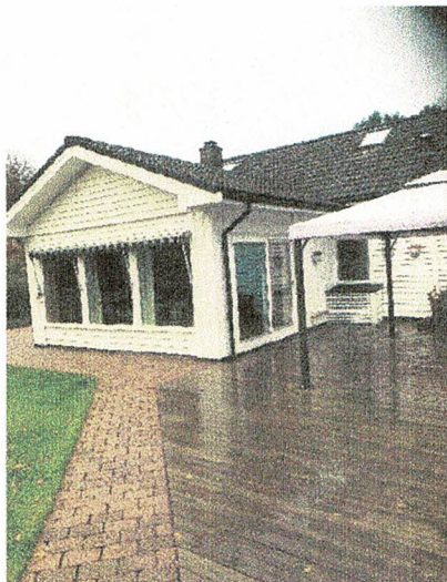
FASADE MOT SØRØST
