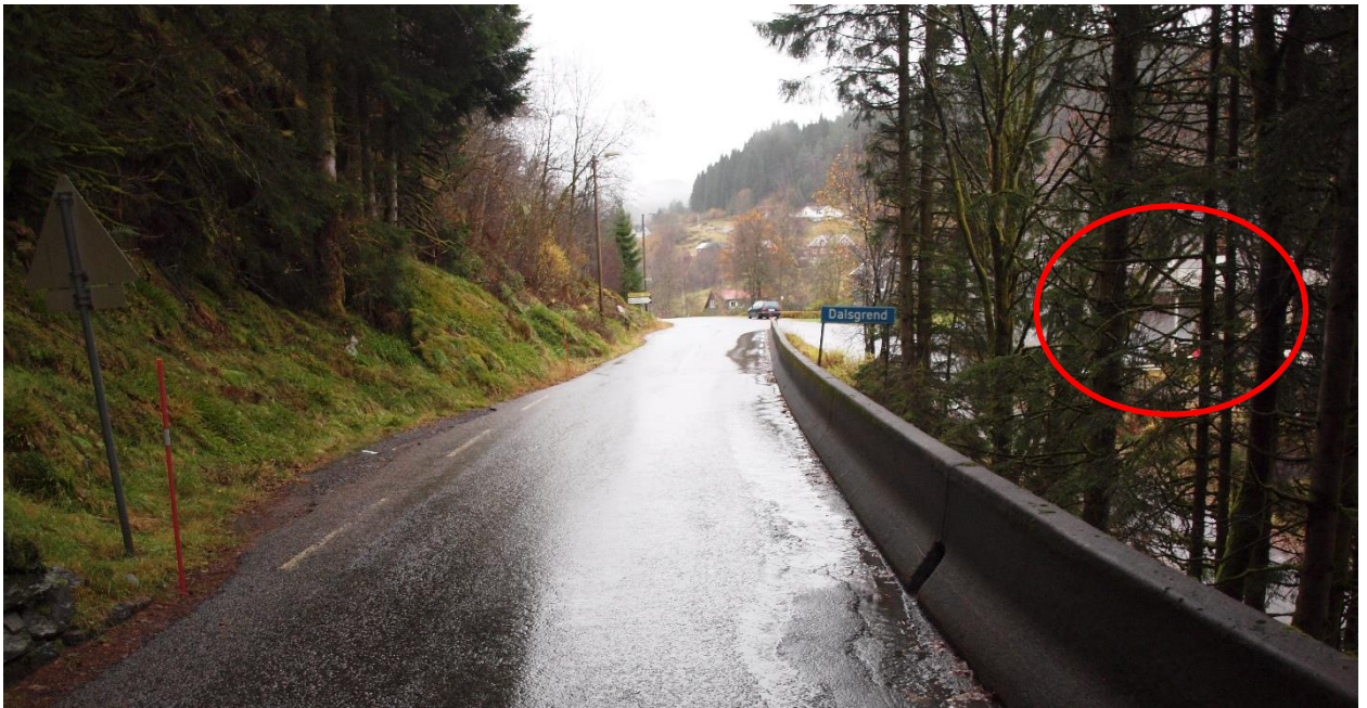
Figur 1-9. Støpekanten på veien stenger hindrer nedfall fra skråningen å nå huset (rød ring).
