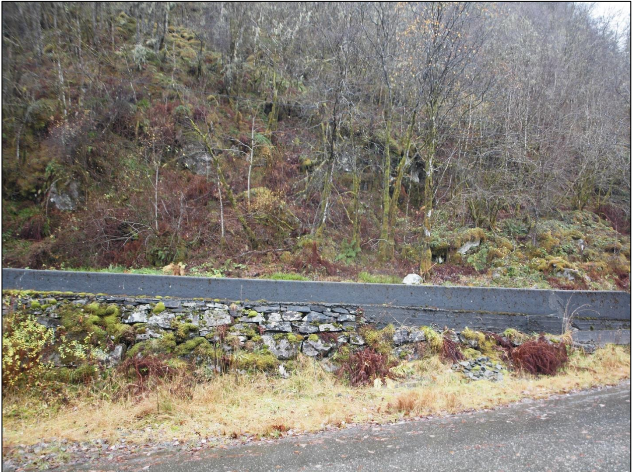
Figur 1-11. Skråningen i vest består av både løse steiner og tett vegetasjon, men har støpekant mellom hus og skråning/vei. I tillegg er det lokal vei øst for støpekant.
