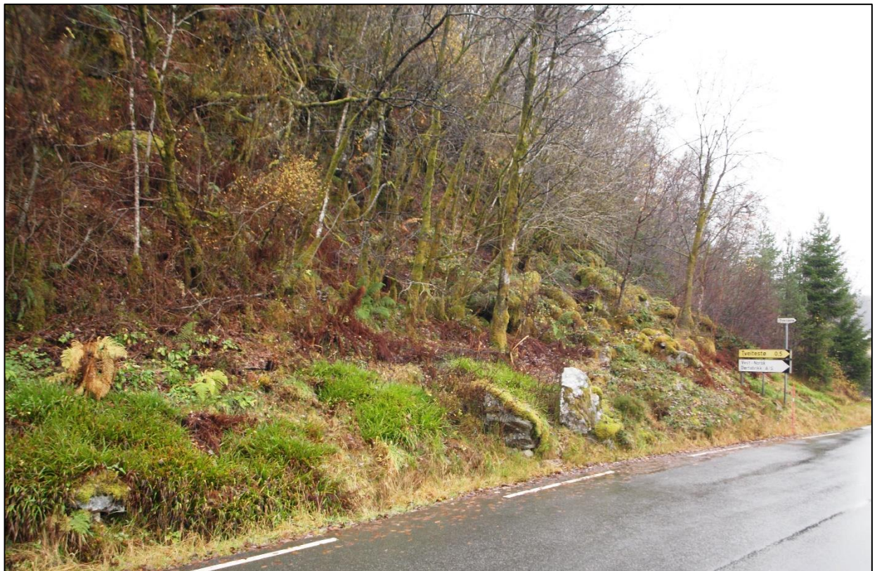
Figur 1-10. Nederste del av skråning i vest har en flate som hindrer nedfall å nå veien.
