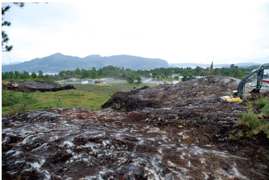
Bilde 22. september 2015. Walde sprenger, vi graver. Ingen bekk over området.
