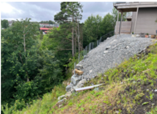
Skråning mellom gbnr. 323/622 og 623.
