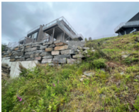
Mur på gbnr. 323/622.
