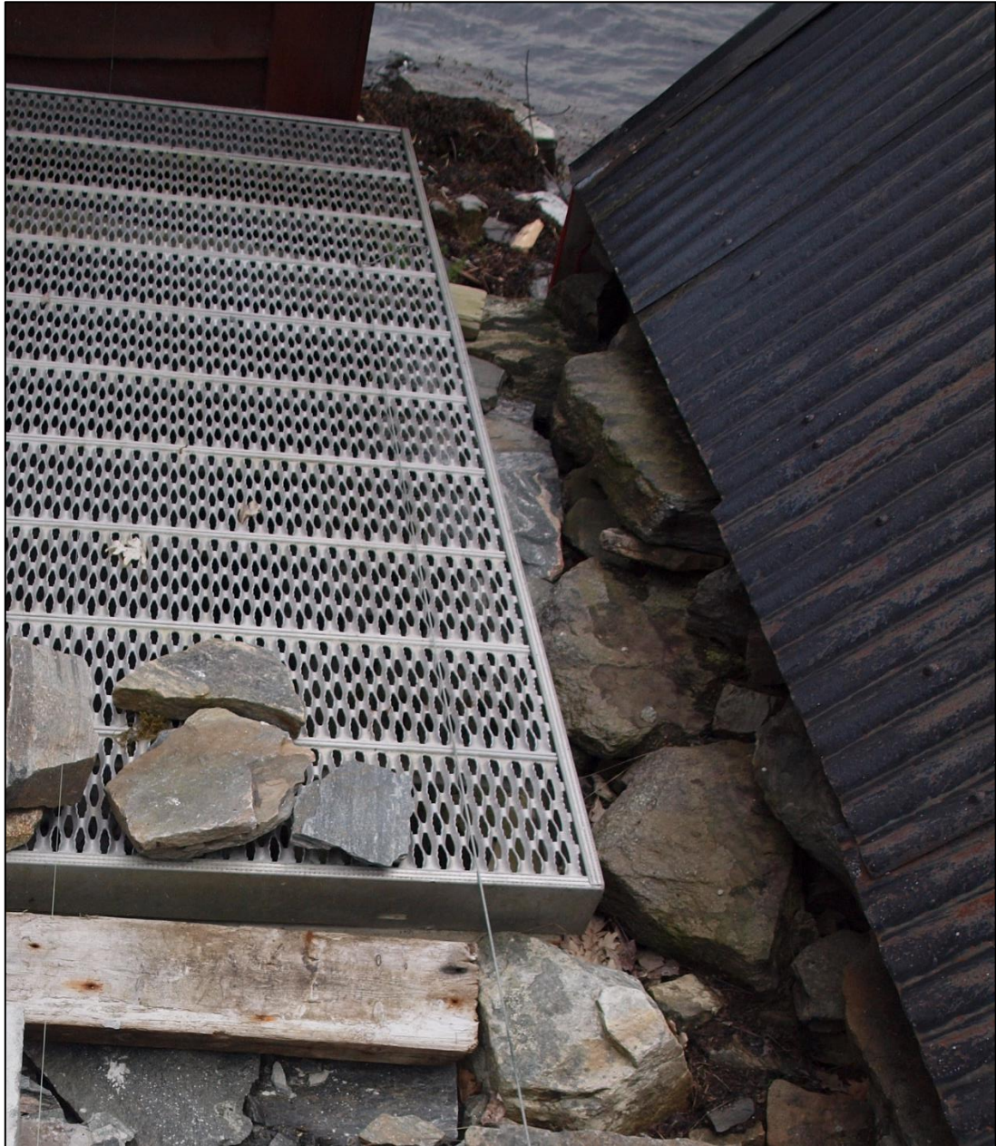
Figur 1-4. Muren sett ovenfra.
