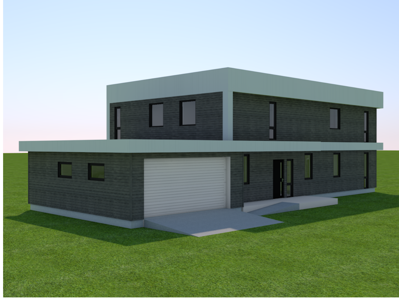
LT vindu må holde formel iht. tek 17§ 13-7. Ag = 0,07 \cdot ABRA / LT (Kontrolert med LT = 0.70 )
