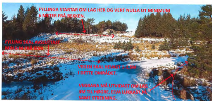
Fig. 2. Bakken lengst borte skal jamnast (planerast) ut om lag ned mot der den stripla lina markerer at bakkenivået vert nådd. Sjå òg fig. 4. I tillegg må vegen i framkant utvidast i innersvingen. Dette då den i dag er for krapp slik at det ber utfordrande å kome forbi med større bilar. Elva som vegen kryssar her, må leggjast i røyr om lag 3 meter utover dagens situasjon dvs frå vegen og om lag til den stripla lina. Vegen må òg hevast om lag 1-1,5 m i denne svingen. Utover dette skal elva framleis ligge open som i dag, men den må reinskast når det er naudsynt. I dette området ligg det ein kommunal vassleidning som det lyt takast omsyn til.
