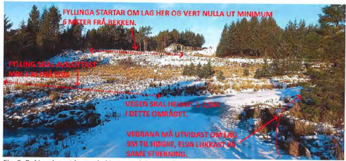
Fig. 2. Bakken lengst borte skal jammast (planerast) ut om lag ned mot der den stripla lina markerer at bakkenivået vert nådd. Sjå òg fig. 4. I tillegg må vegen i framkant utfidast i innersvingen. Dette då den i dag er for kropp slik at det ber utfordrande å kome forbi med større bilar. Elva som vegen kryssar her, må leggast i røy om lag 3 meter utover dagens situasjon dvs frå vegen og om lag til den stripla lina. Vegen må òg hevast om lag 1-1,5 m i denne svingen. Utover dette skal elva framleis liggje open som i dag, men den må reinskast når det er naudsynt. I dette området ligg det ein kommunal vasseleiing som det lyt takast omsyn til.
