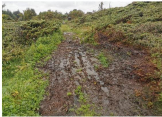
Om lag halvvegs på markavegen er det ein lengre bakke med stigning 1:10. For å gjera denne stigninga slakkare ynskjer me å leggja om vegen på dette partiet som vist i kart. Traseen vert då om lag 45 meter lengre.
