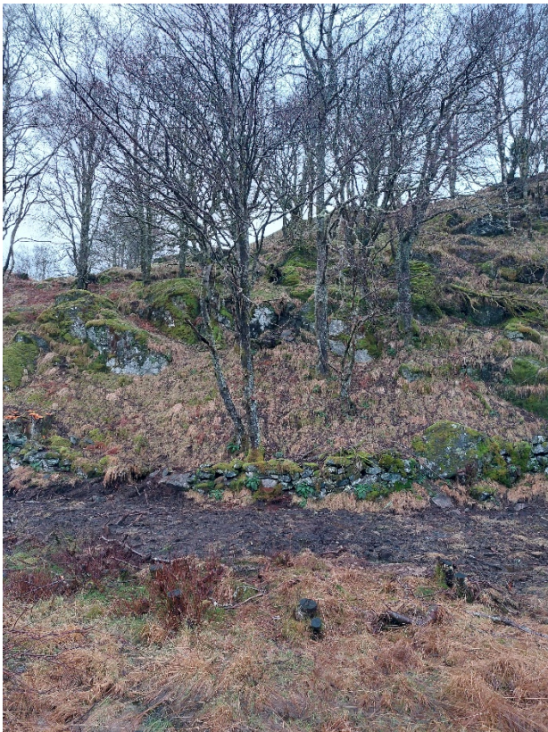
Bilete frå synfaring: Muren har eit uryddig preg med blanding av store og små steinar.
