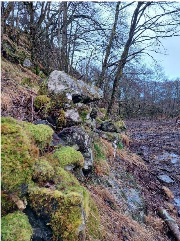
Bilete frå synfaring: ustabile steinar som kan stå i fare for å rasa ned
